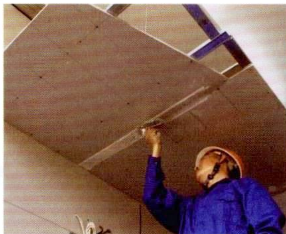
图 10 专用胶填平, 贴上抗裂接缝带。
