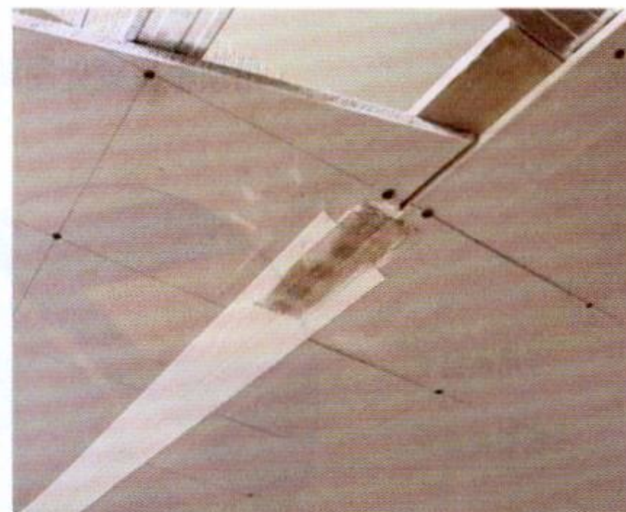
图 11 抗裂接缝带布面层朝下。
