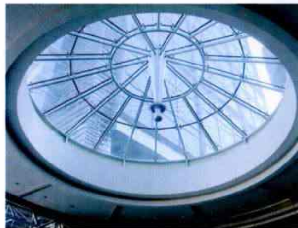
轮辐式拉杆采光顶实例图片
