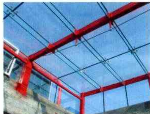
玻璃梁结构采光顶实例1
