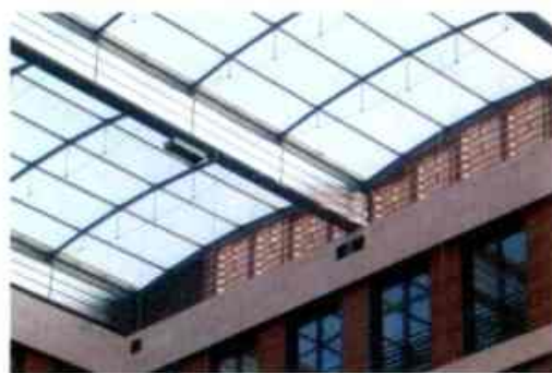
张拉弦拉索桁架采光顶实例
