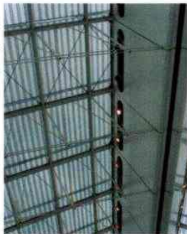
图2 拉杆采光顶实例
