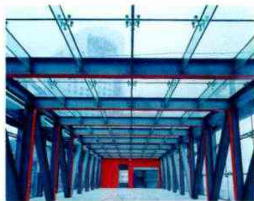
玻璃梁结构采光顶实例2
