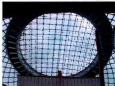
图4 拉索拉杆采光顶实例
