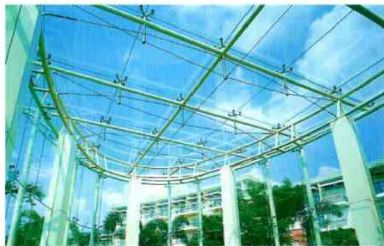
拉索桁架采光顶实例图片
