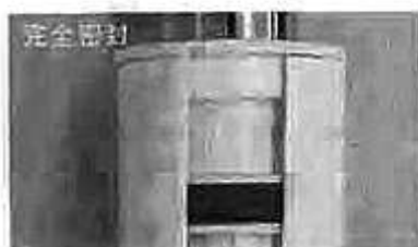
中财工艺全密封排水，材质 转换处密封，可拆卸可检修
