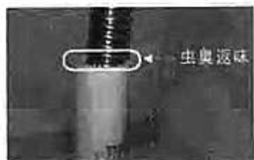
普通工艺材质转换下水口 不密封，产生虫臭返味
