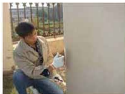
无机抗渗界面剂施工
