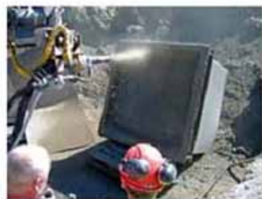
喷射混凝土
