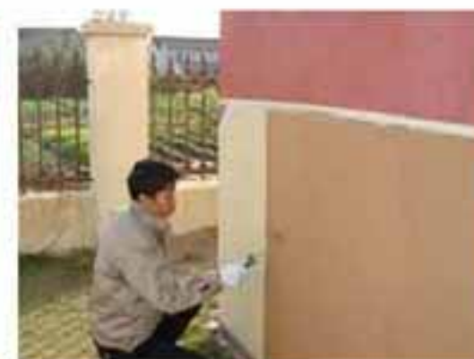
无机粉末涂料施工
