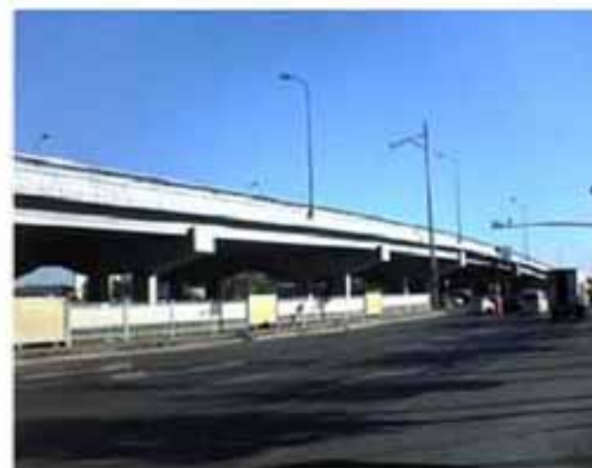
2008奥运会二、三、四环立交桥桥梁粉刷
