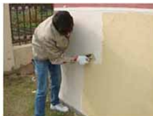
无机饰面砂浆刮抹
