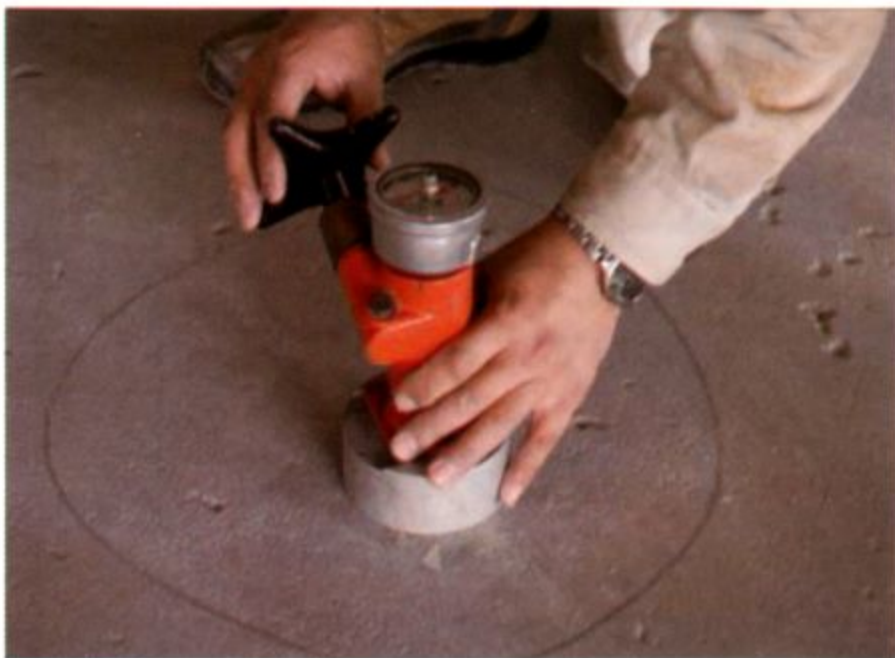
基层拉拔检测
