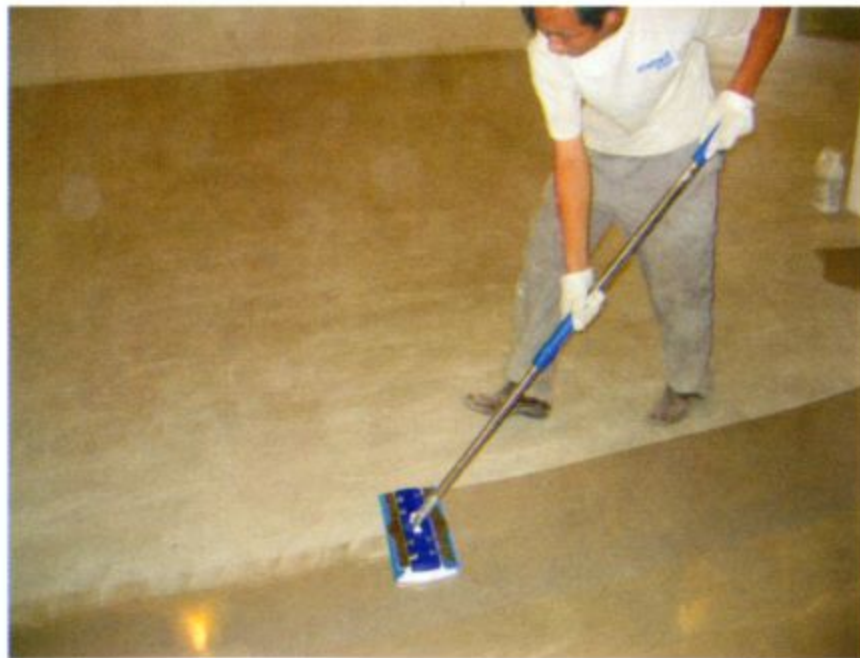
封闭剂施工
