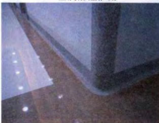
石材防撞护角及石材踢脚
