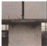
钢结构外墙横板 专用托板示例图
