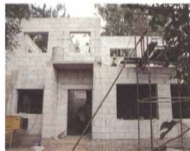
砌块低层承重结构工程示例图
