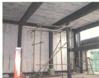
钢结构内墙竖板示例图
