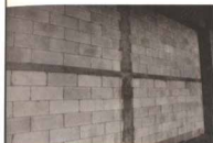
砌块填充内墙立面示例图
