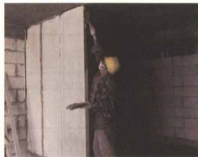
内墙竖板垂直找平示例图
