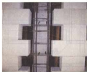
构造柱预留钢筋示例
