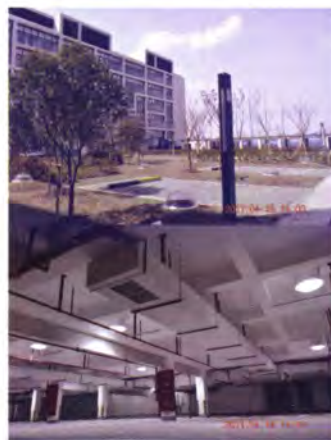
上海电气地下车库
