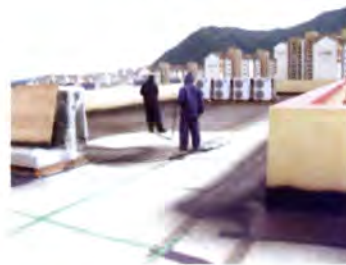
混凝土屋面防水工程
