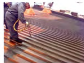
彩钢板屋面防水工程
