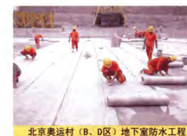
北京奥运村（B、D区）地下室防水工程
