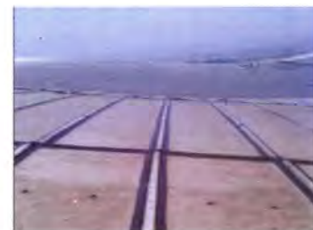
阳光屋顶 PC 罩防水工程
