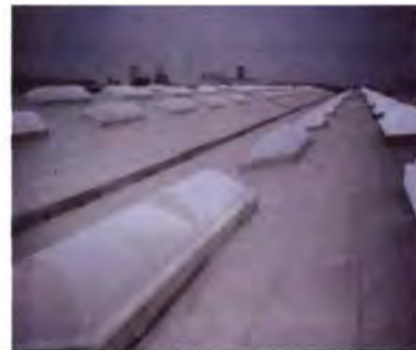
1.5 \times 6m 透明玻璃钢采光罩
