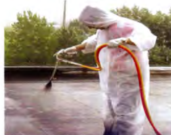
喷涂施工示意图
