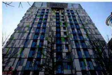
北京新派白领公寓 产品: 佳美埃特板 面积: 5000 m 2 应用: 外墙 类型: 旧楼翻新
