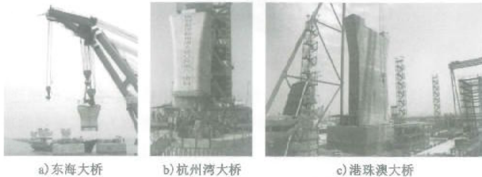
图 9.3-12 采用预制拼装桥墩的典型工程
