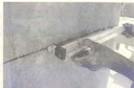
图8 将龙骨插入可调式定位部件
