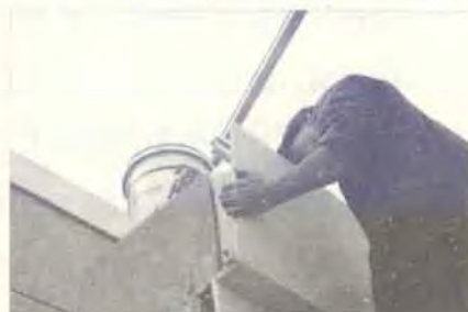
图10 将板边插入龙骨卡槽
