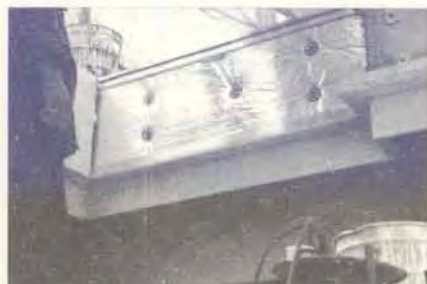
图9 将玻璃棉保温层用尼龙胀栓固定
