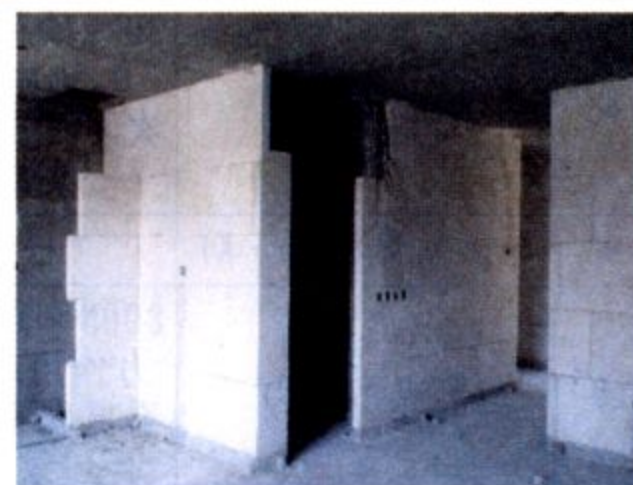
砌块砌筑墙体
