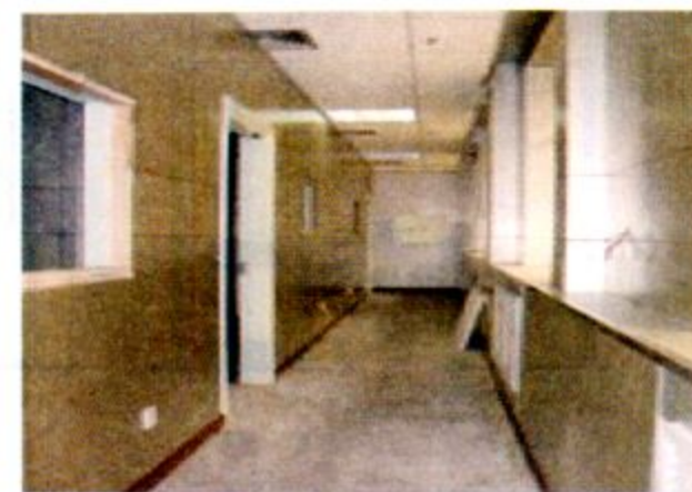
铝塑板面轻钢龙骨防护隔墙
