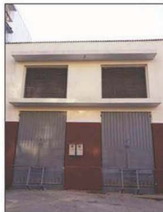
变压器室钢门及排风窗
