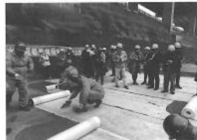
新机场高速公路地下综合管廊防水工程
