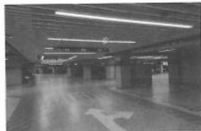
霄云路 8 号车库 定义“停车场是建筑第一大堂”理念
