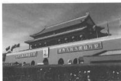
北京天安门城楼及城台防水工程
