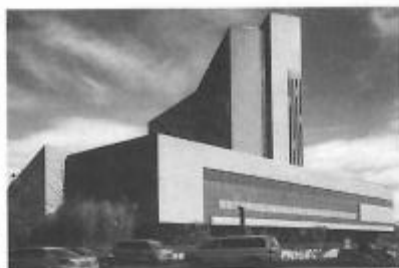
北京昆泰望京酒店地下、卫生间、屋面防水工程
