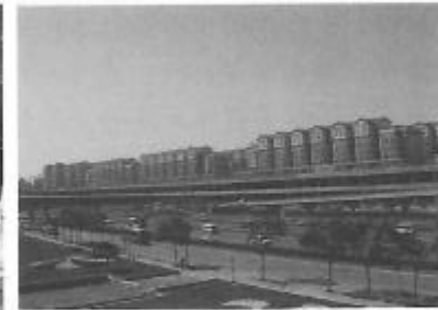
四惠地铁大平台种植屋面防水工程
