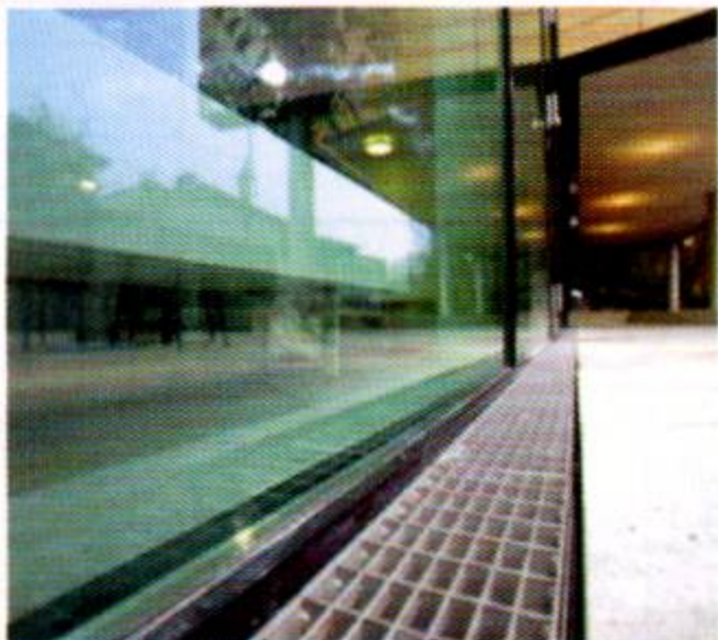
阳台成品渗排沟
