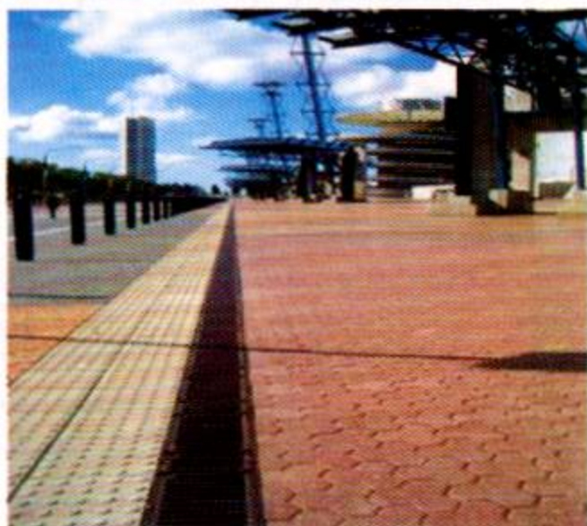
V型排水沟
