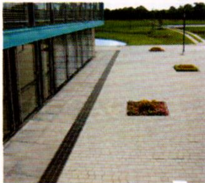
V型排水沟
