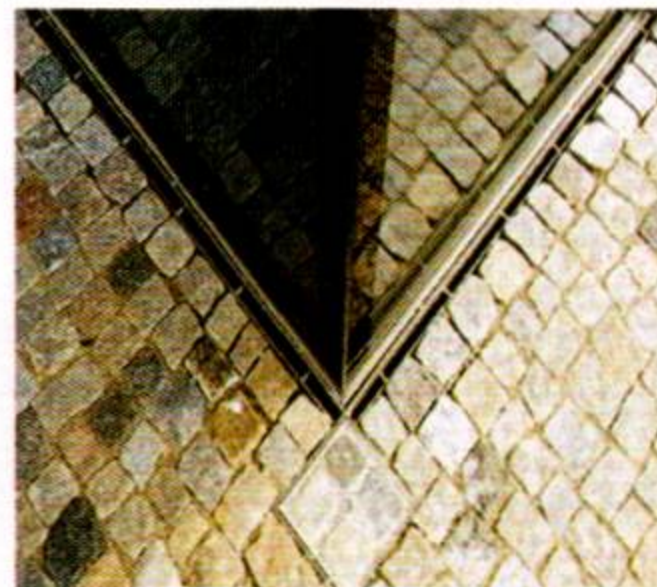
缝隙式排水沟
