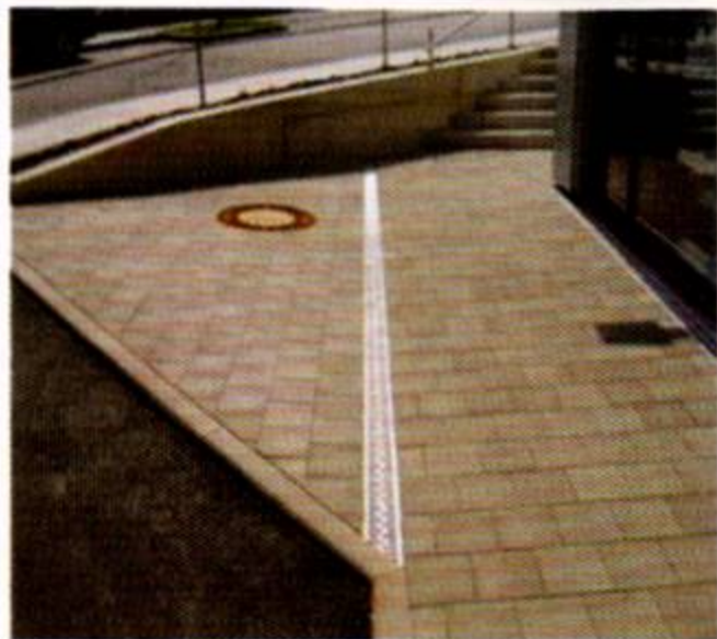
V型排水沟
